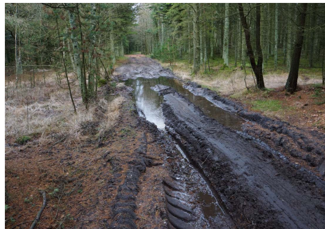
Skader på skovvejen efter et flisprojekt.
